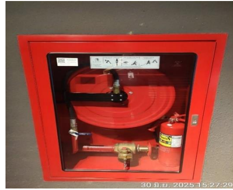
ตู้สายฉีดน้ำดับเพลิงพร้อมอุปกรณ์
