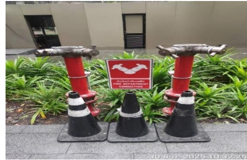
หัวจ่ายน้ำดับเพลิงชั้นดาดฟ้า
